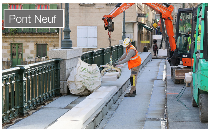
Les travaux sur le pont Villegoudou se poursuivent par la mise en place des bordures.
