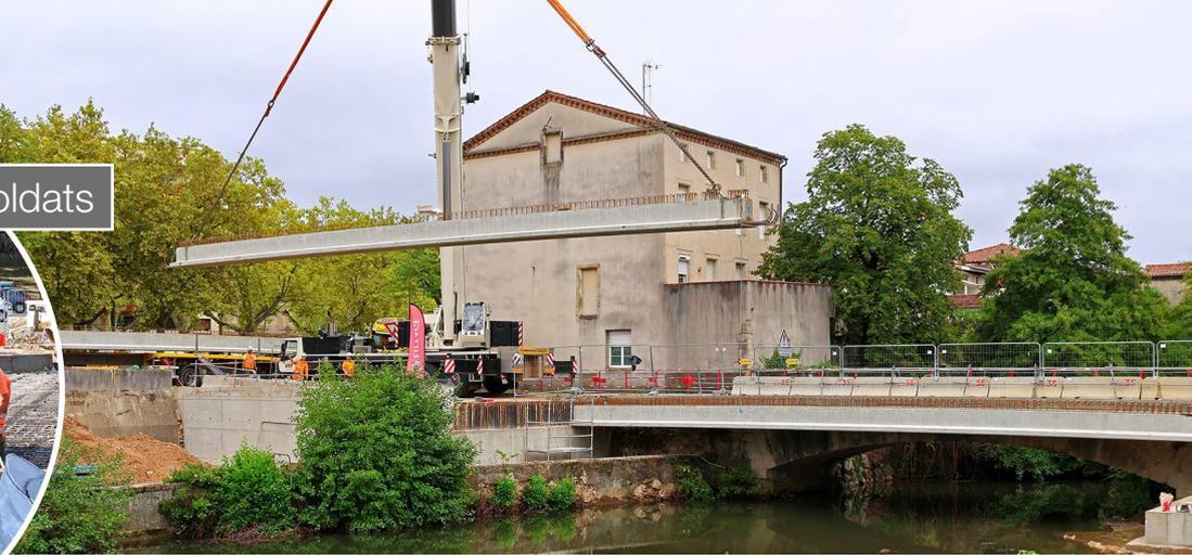
Les travaux d'élargissement du pont des Soldats sont entrés dans une phase essentielle, avec la pose des neuf poutres en béton de 25 mètres de longueur et le coulage de la dalle.
