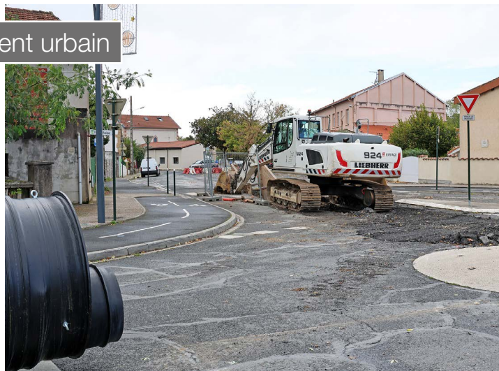
... et la pose du réseau pluvial est en cours dans ce même secteur.
