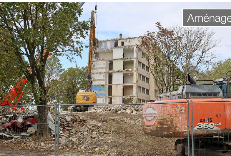
Le grignotage de la barre du quartier de Laden/Petit-Train continue...
