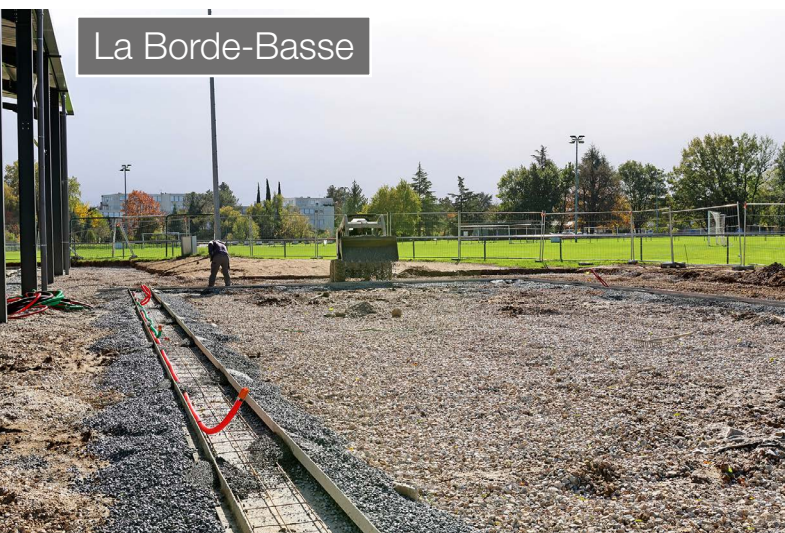
Les travaux de fondation des pistes de padel ont débuté.
