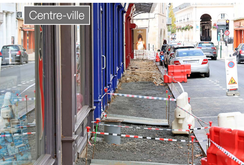
La deuxième phase de réfection des trottoirs de la rue de la Libération a commencé.
