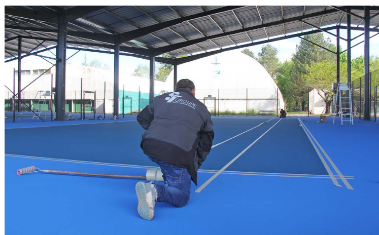
Complexe de la Borde-Basse : les travaux d'aménagement des terrains de tennis et de padel touchent à leur fin.
